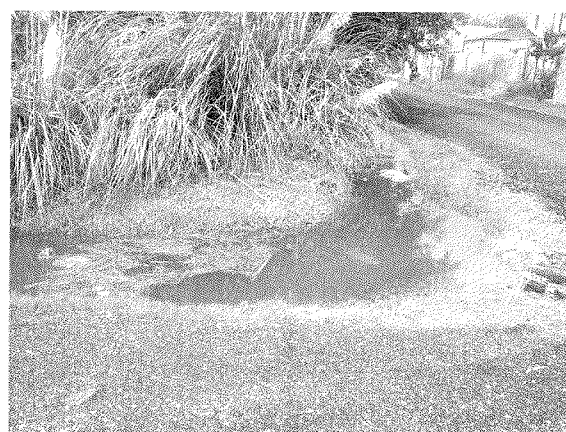
Fotografía 12. Acumulación de agua sobre zanja en 5 y 501
