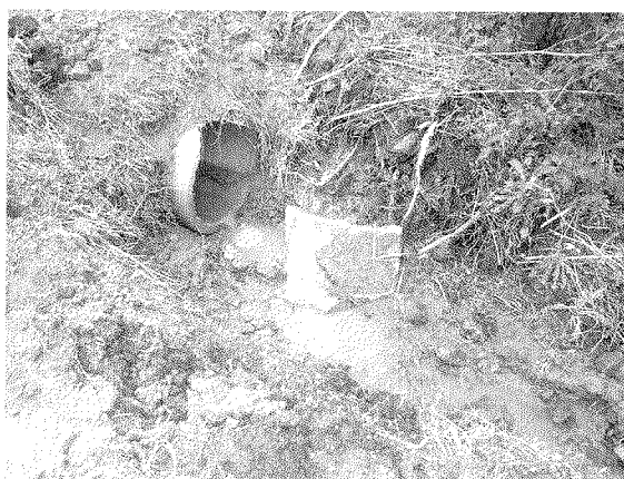
Fotografía 13. Zanja socavada por debajo de nivel de alcantarilla en 2 y 489
