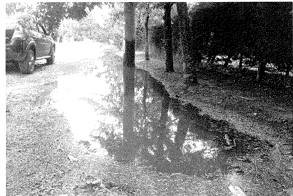
Fotografía 8. Acumulación de agua sobre zanja mal conformada en 11 y 488
